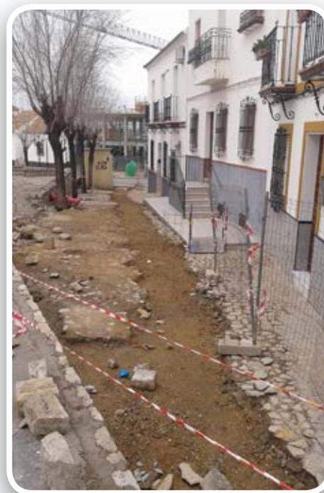
se llevó a cabo el abastecimiento, saneamiento y pavimentación de los viales 7 y 8, así como la obra civil de infraestructuras eléctricas, además de la instalación de transformadores, la construcción de la línea de media tensión que conecta los dos centros de transformación y el trazado de la red de baja tensión que permite el suministro eléctrico a las distintas parcelas industriales.
